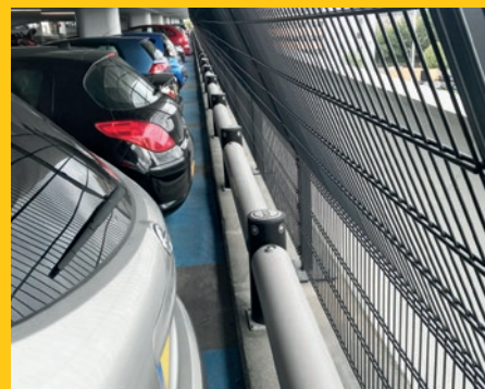
Elastyczna bariera parkingowa zabezpieczająca granice miejsc postojowych na parkingu wielopoziomowym.
