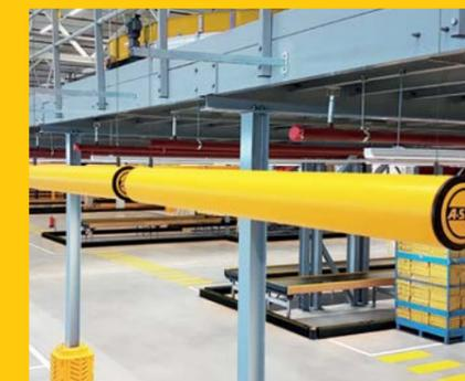
Barra di allarme multipla che protegge una struttura aerea.
