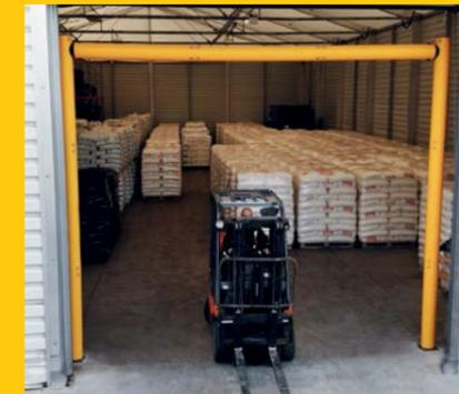
Il limitatore di altezza fornisce una guida visiva e protezione fisica ai conducenti dei veicoli.
